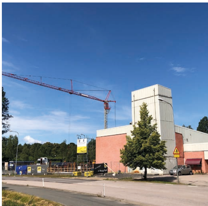
Ombyggnad av Älmbults vattenverk
